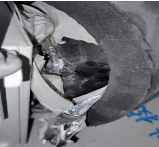
图 2 模块出口段软管连接情况
