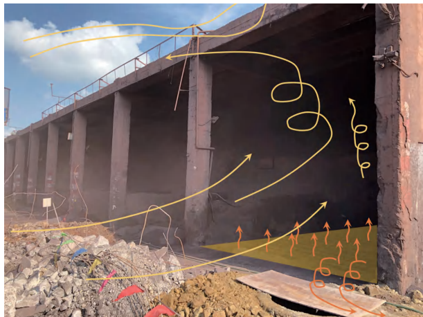
图1 某工业半开放工业物料转运点
